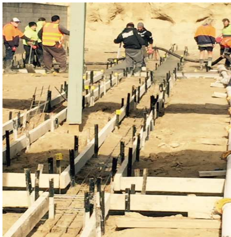
Concrete pour Ranges 3 & 4 (1.2km's of boxing)
